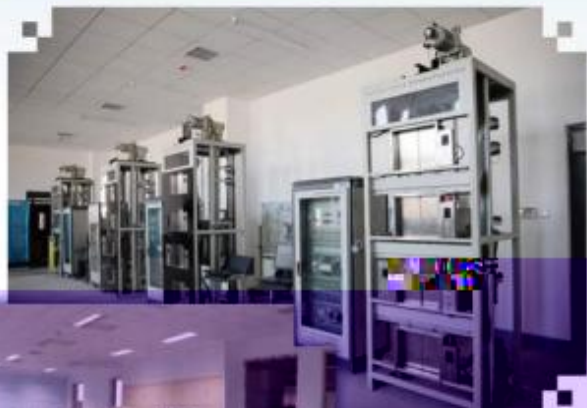
智能电梯安装调试 维护训练场所
